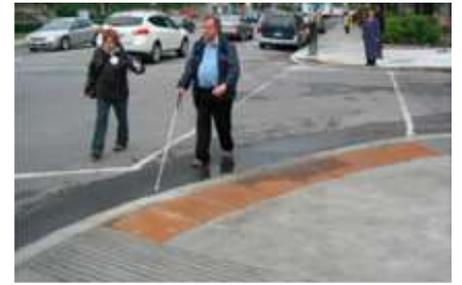
Fig32b. Pavé ou ligne podotactile, Source : Direction des transports Montréal
