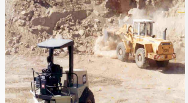
Figure 5 Construction du barrage de Halhal, 1997
