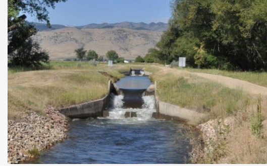
Figure 6 Structure de chute du canal
